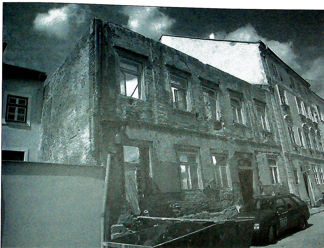
Obr. 6: Smetanova č. 8, celkový pohled na „rekonstrukci“ domu.
