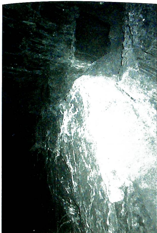
Obr. 4: Strop podzemní vyrubané prostory ve svahu pod čtvrtí Žižkov
