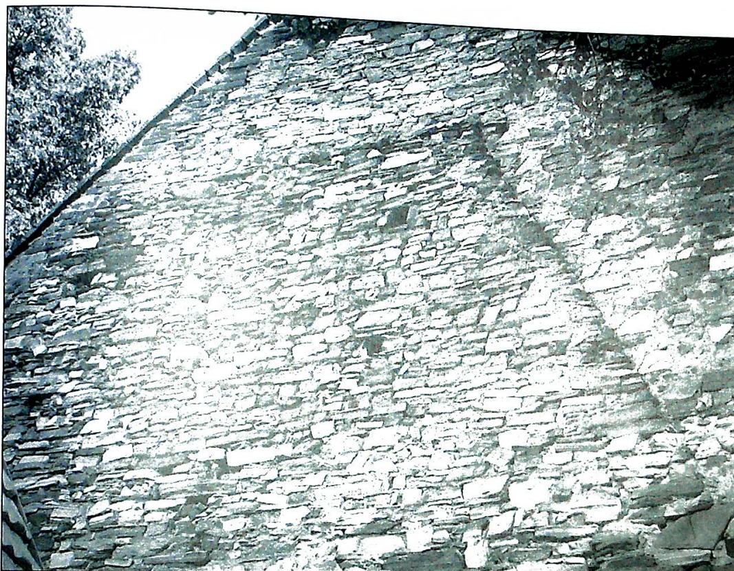
Obr.5 Západní průčelí kostela sv. Víta. Detailní pohled na původní řešení štítu v návaznosti na římsu ukončující jižní stěnu kostelní lodi ve třetí rozpoznané stavební fázi..
