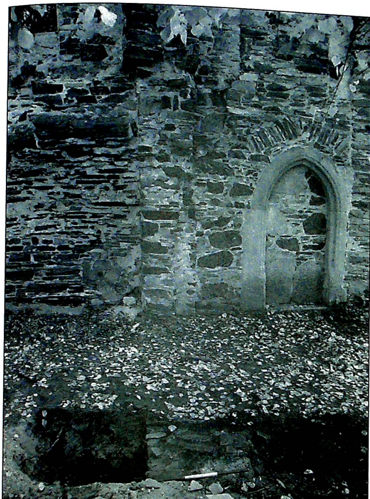
Obr.9 Sonda v prostoru místnosti severně presbytáře kostela sv. Víta. Dobře je patrné řešení místnosti vůči vlastnímu presbytáři.
