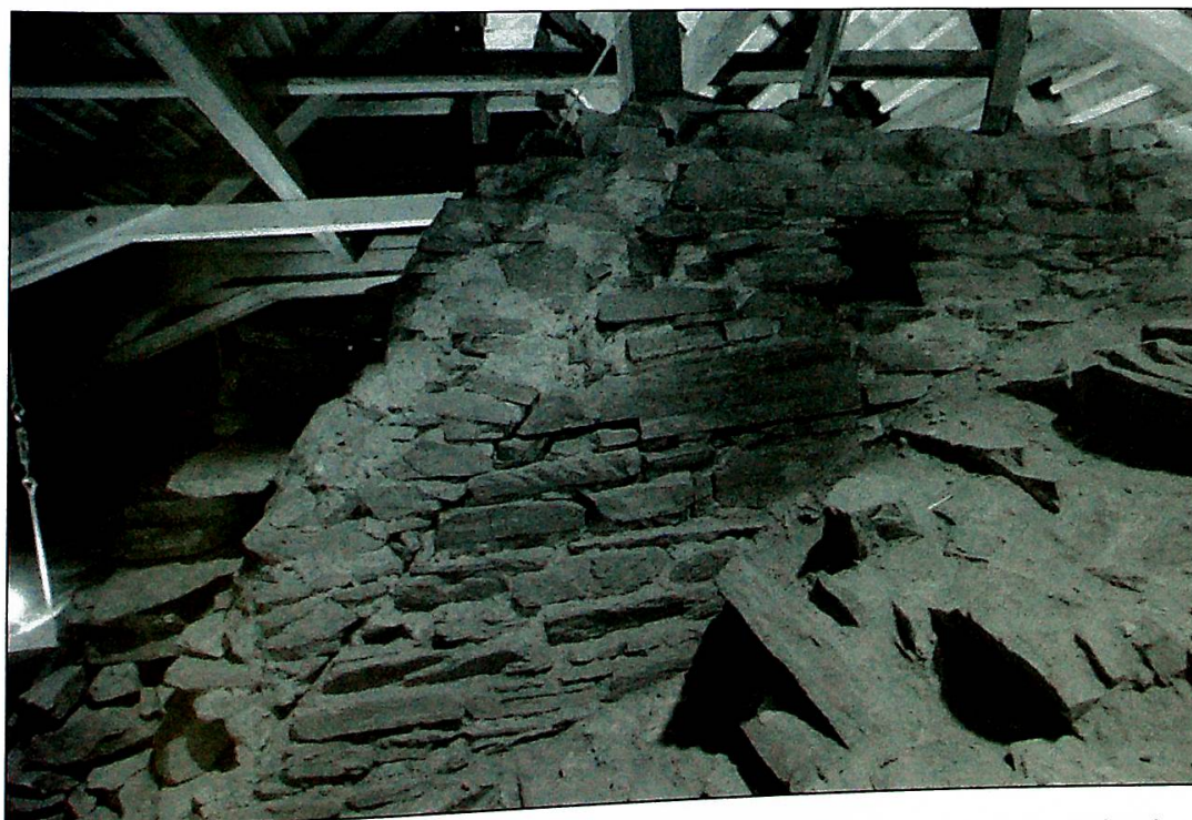
Obr.6 Půda kostela sv. Víta s původním štítem nad vítězným obloukem, pohled od západu. Vidět je rozšíření štítu v mladší stavební fázi. V popředí rub valené klenby presbytáře.
