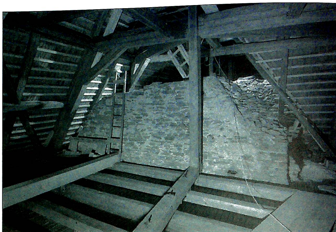
Obr.7 Pohled na původní štít nad vítězným obloukem z prostoru nad kostelní lodí. Vzadu pak je patrná konstrukce vystavěná na vynášecím pasu rozepřeném mezi opěrnými pilíři.
