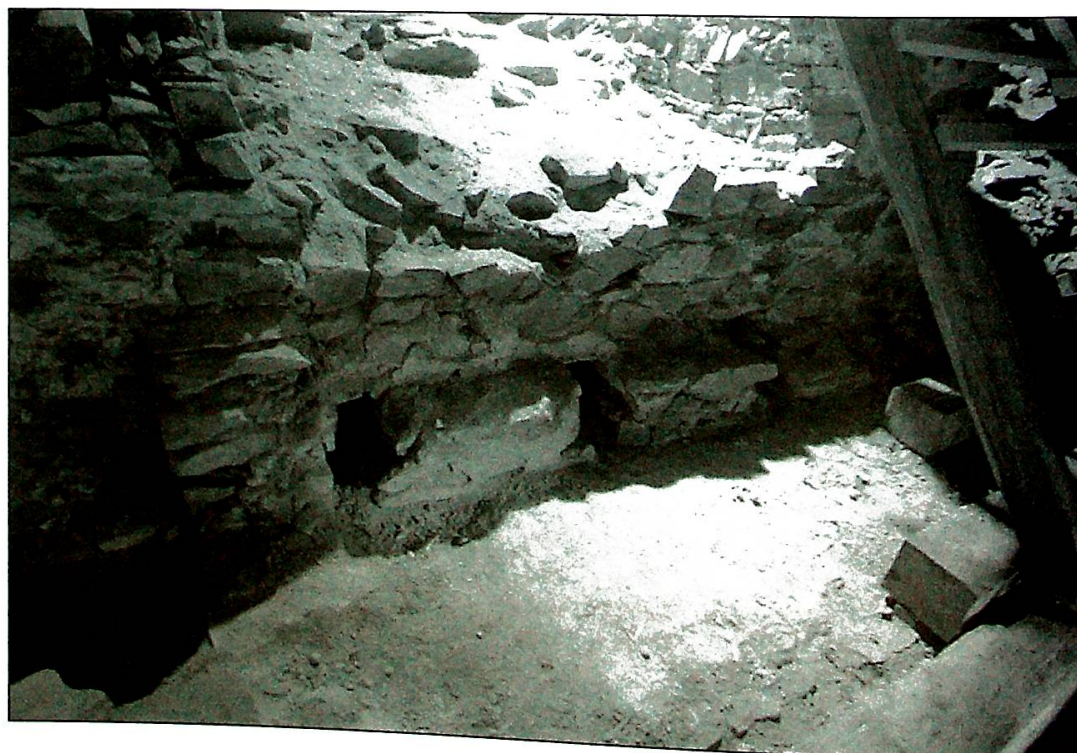
Obr.8 Pohled na korunu jižní strany presbytáře se čtveřicí trámových kapes, které tvořily původní strop kaple Umučení Páně.
