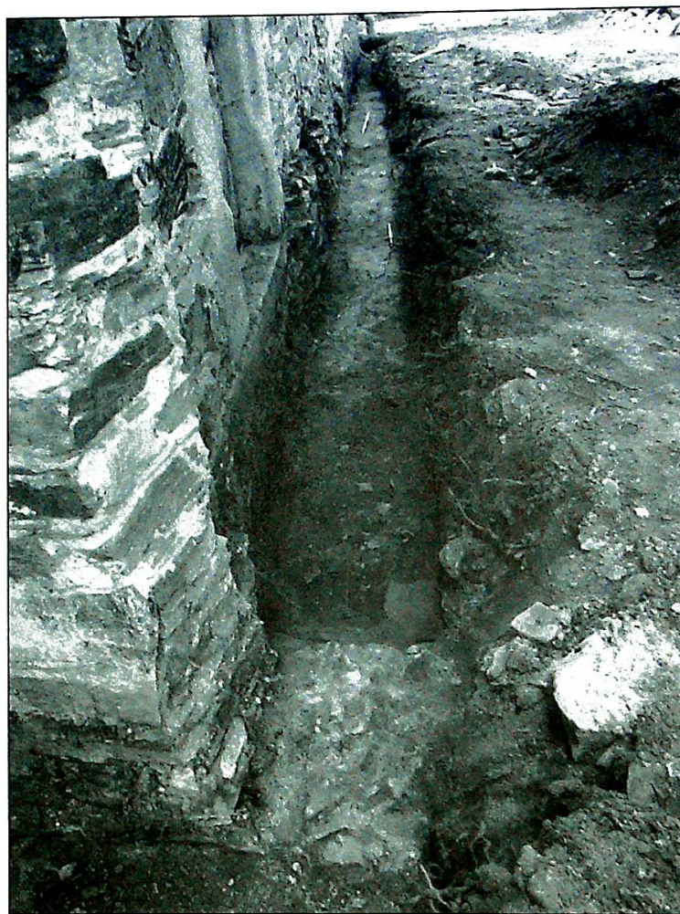
Obr.11 Pohled do výkopu pro odvlhčení severní stěny kostela. V popředí jižní špaleta vstupu do místnosti při západní straně presbytáře se základy prahu. Při severní zdi kostelní lodi je vidět základ zdiva ambitu.
