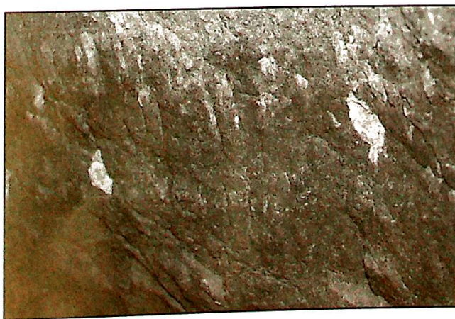
Obr. 9: Detail jz. stěny se stopami po želízkování. Foto David Hromada.
