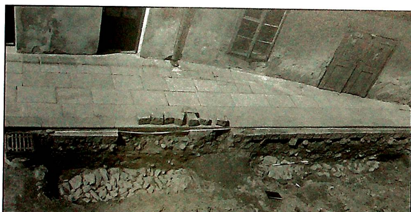
Obr. 16: Kamenná zeď odkrytá v trase vozovky v Palackého ulici v blízkosti věže sv. Ducha.
