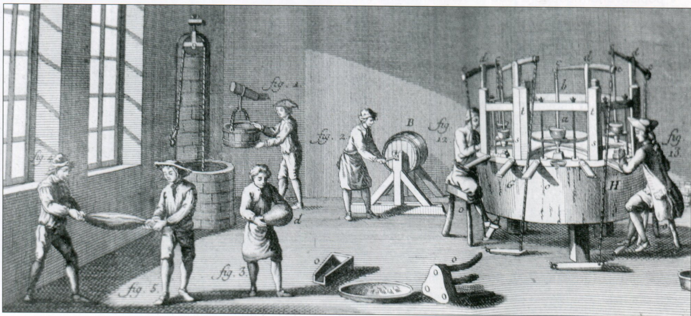
Obr. 30: Pohled na špendlíkářskou dílnu v 18. století. Převzato z: Diderot 1773, Pl. III.
