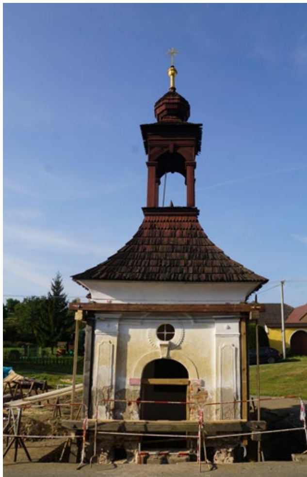
Obr. 2: Kaple se zvoničkou z roku 1843.
