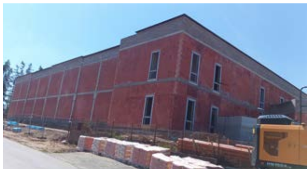
Stavba depozitáře – stav k dubnu 2025.
