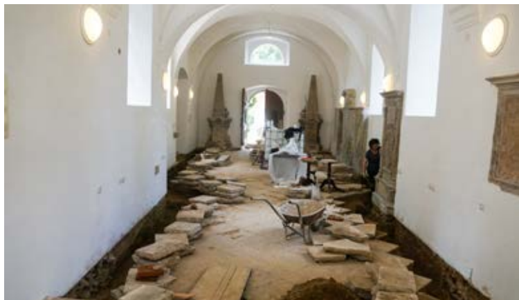
Obr. 4: Interiér kostela sv. Ducha po odstranění dlažby.
