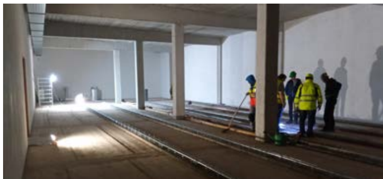
Montáž kolejnic pro pojezdové regály, budoucí depozitář archeologie.
