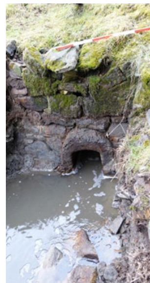
Vzdušná strana hráze s funkčním potrubím před vyjmutím
