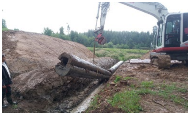
Vytažení historického potrubí z hráze
