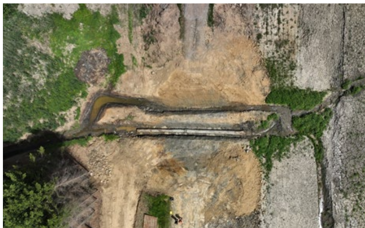
Uložení potrubí, snímek z dronu
