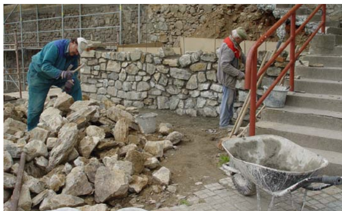
Rekonstrukční práce na polenském hradě, 2005
