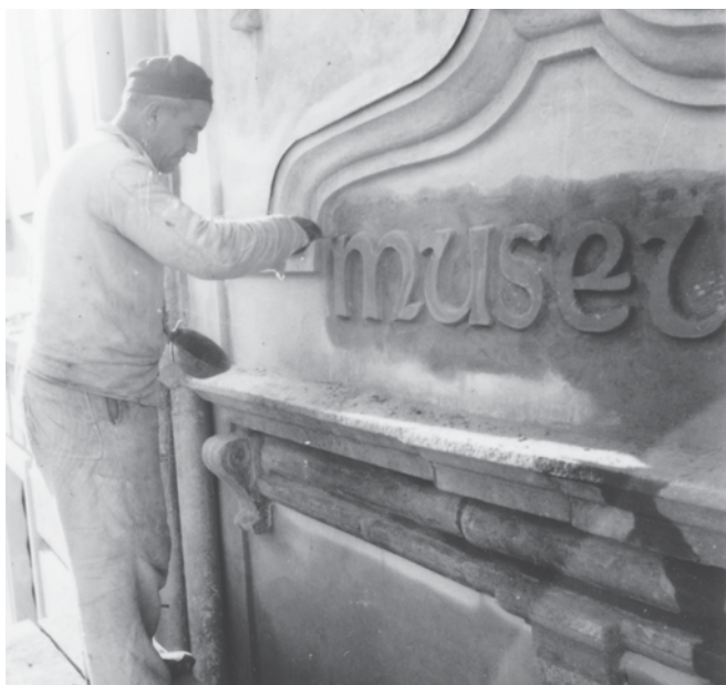
Práce v rámci oprav fasády v roce 1957
