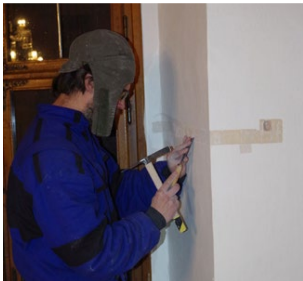
Restaurátor Jakub Kándl při pořizování sond v omítkách
