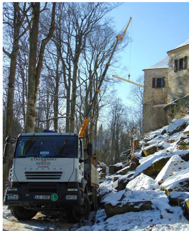
Doprava nových trámů.
