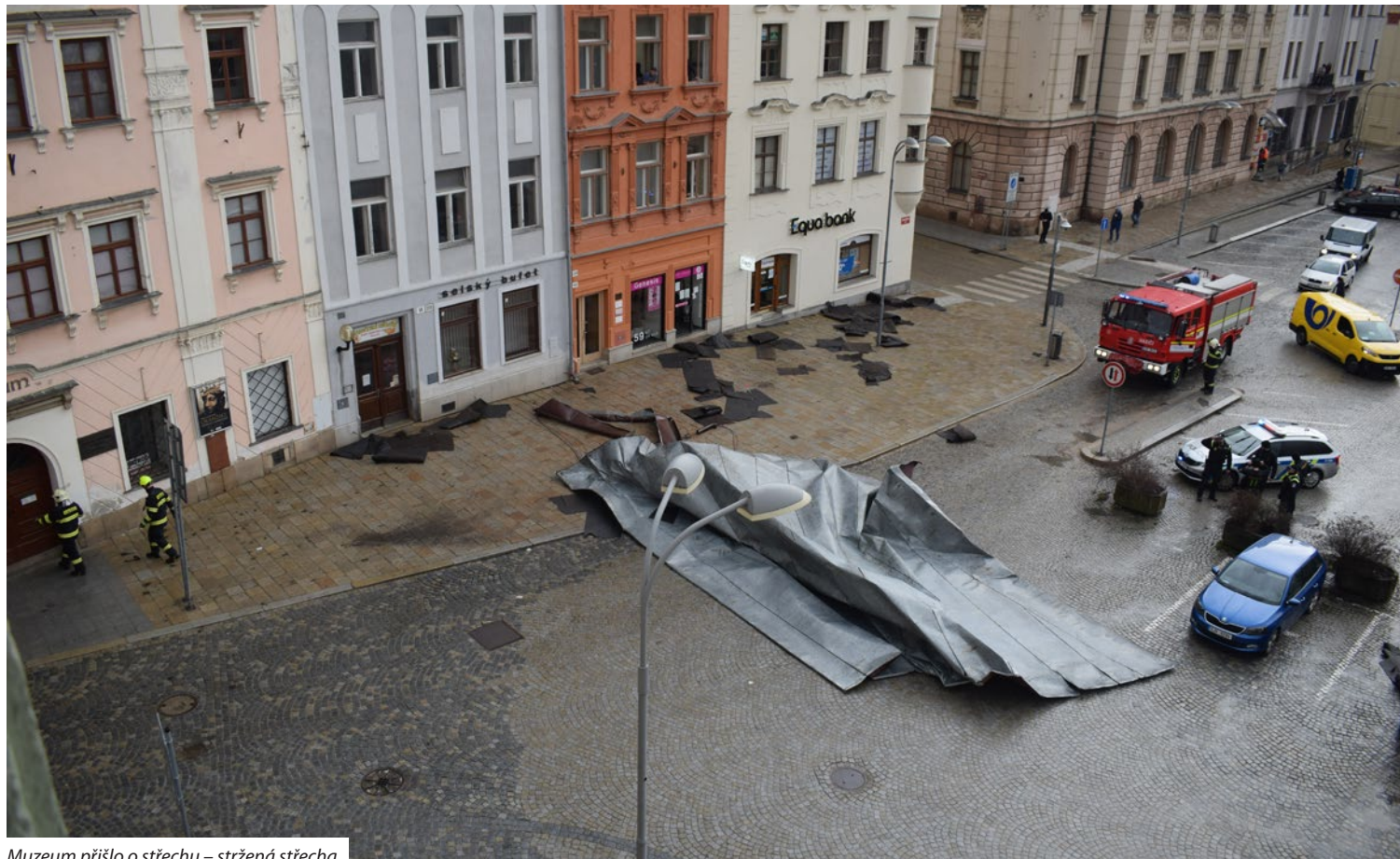
Muzeum přišlo o střechu – stržená střecha
