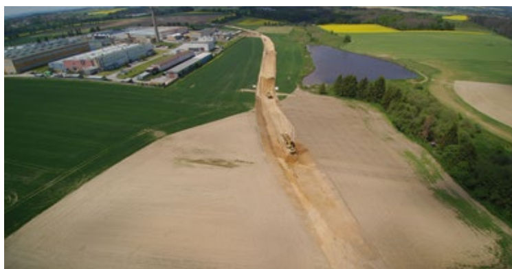
Dokumentace terénních úprav na obchvatu Velké Bíteše. (Foto: M. Krutiš)
