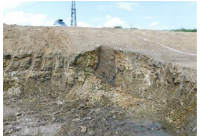
Odkrytá šachta s výdřevou
