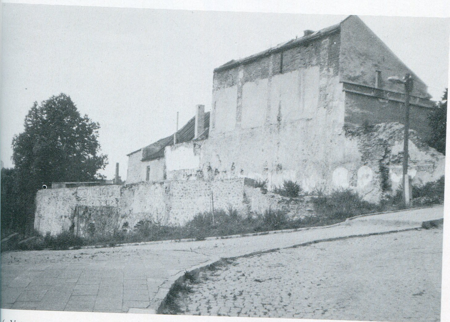
6. Vstup na parkán z Brněnské ulice po zahájení oprav (nedokončený) v r. 1987.
