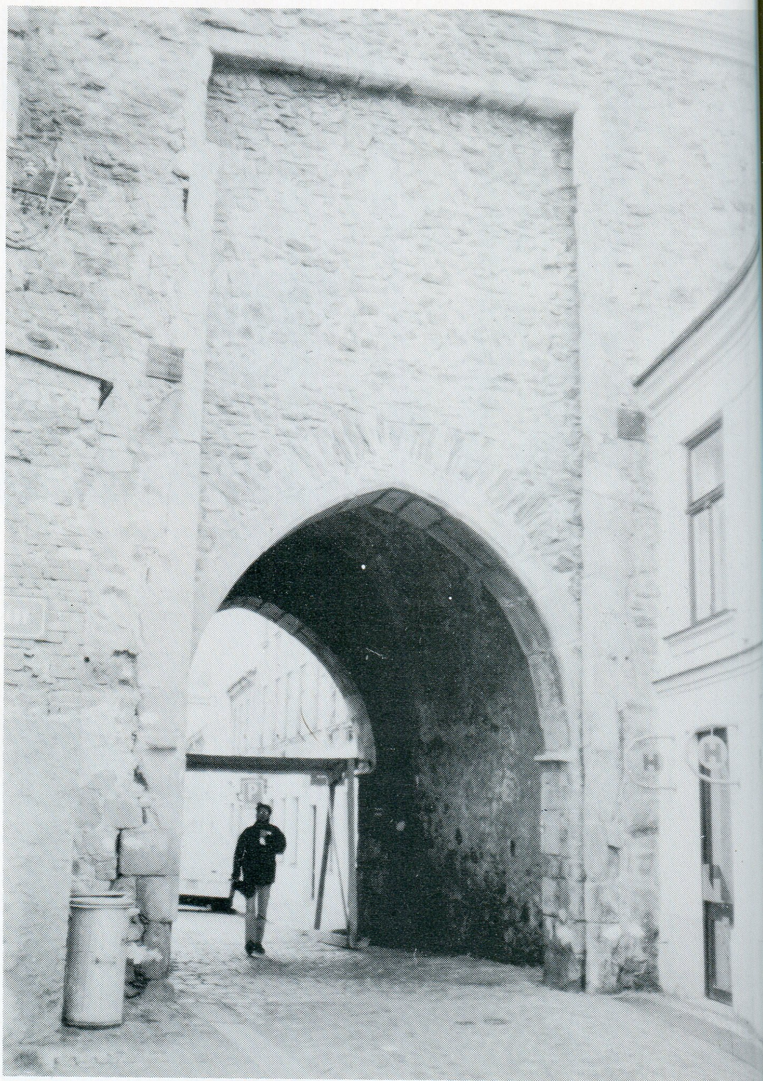
10. Vnější strana brány Matky Boží (po provedené sanaci základů).
