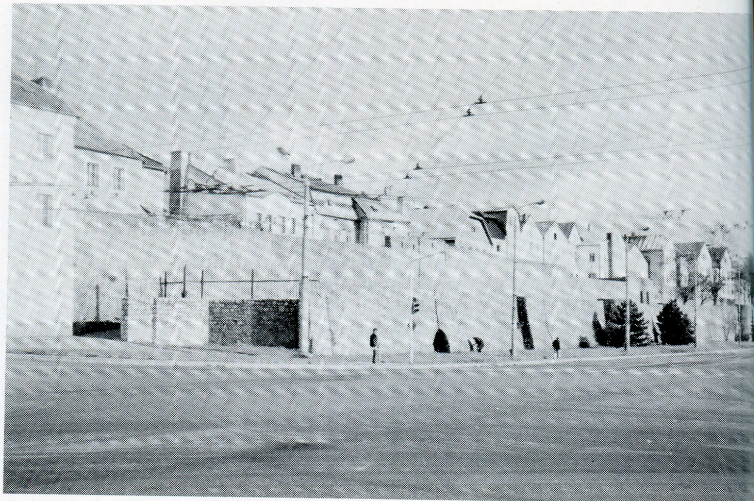
7. Jižní část hradeb po dokončení.
