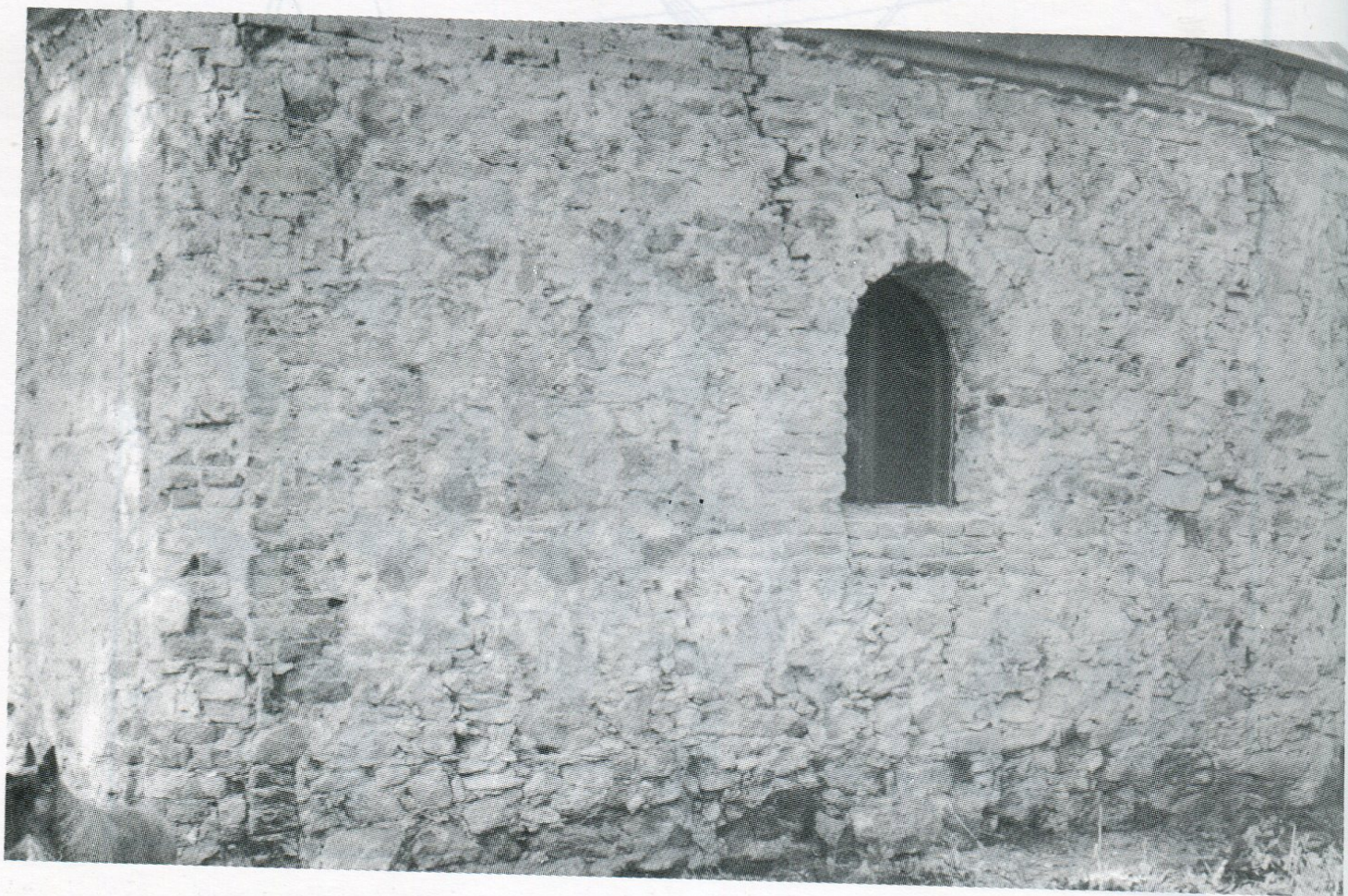
9. Bílý Kámen, nároží s levou boční stranou, stav po odstranění omítek (1994).
