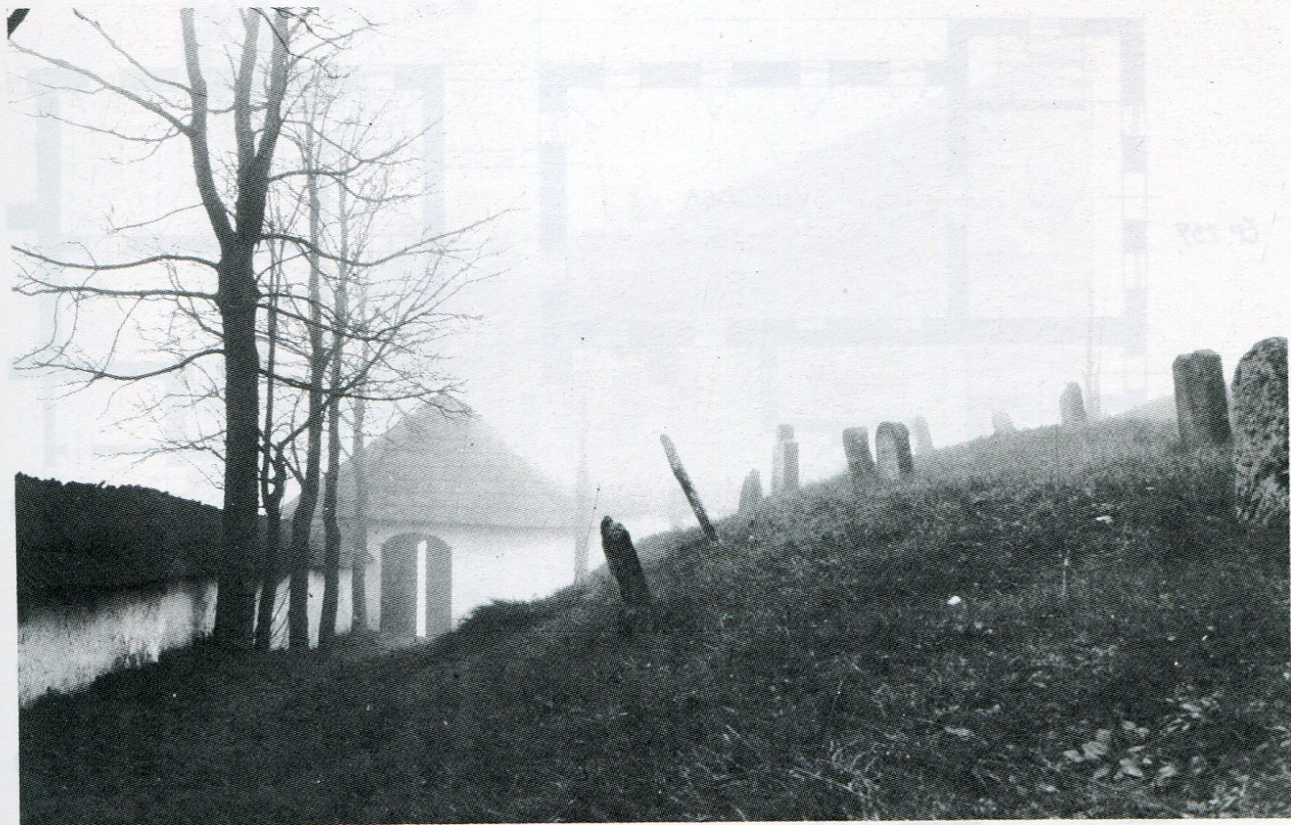
5. Vstupní část batelovského židovského hřbitova s márníci, 30. léta 20. století. Foto Památkový ústav v Brně.
