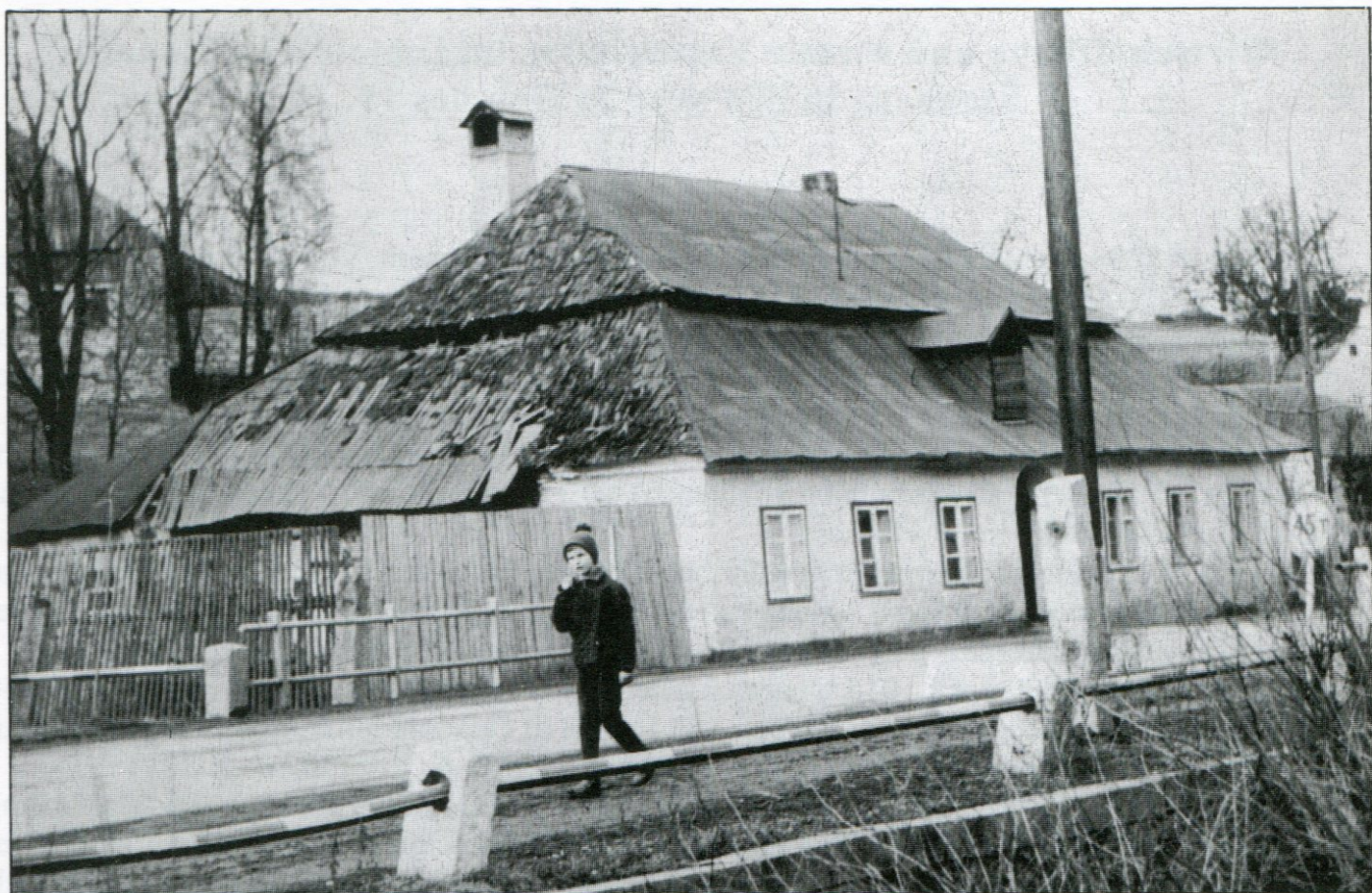
7. Stonařov, dům čp. 194, staré číslování 41. Doklad mizející domkářské zástavby z přelomu 18. a 19. st. při bývalé poštovní erární silnici Praha-Vídeň. Původní krytina šindelová, později plechová. Stav před demolicí k roku 1972. Foto L. Peltan.
