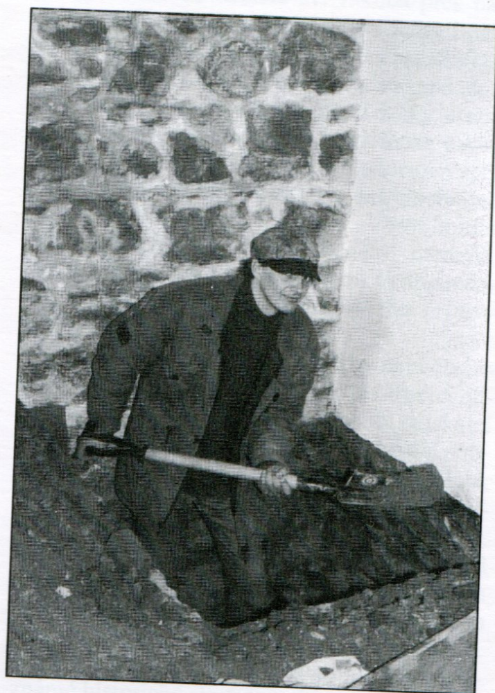
Obr. 5: Vít Milar při hloubení sondy I.
