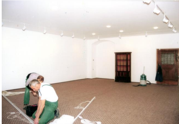
Rekonstrukce výstavní síně (září – listopad 2003)
