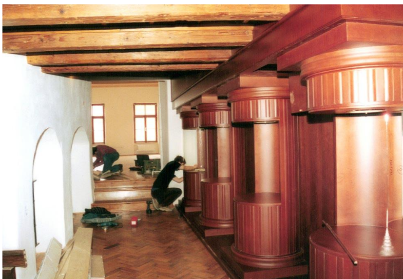
Instalace nového výstavního zařízení pro historické expozice
