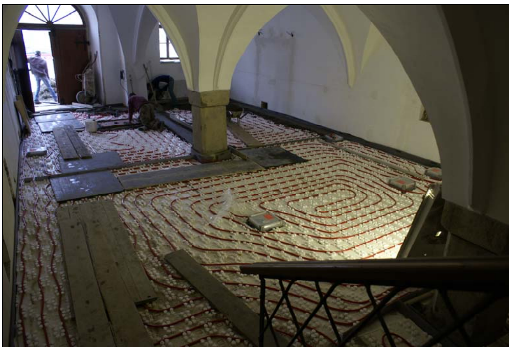
Rekonstrukce přízemí budovy čp. 55 - instalace topného systému.
