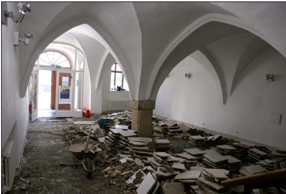
Rekonstrukce přízemí budovy čp. 55 - odstranění staré dlažby.
