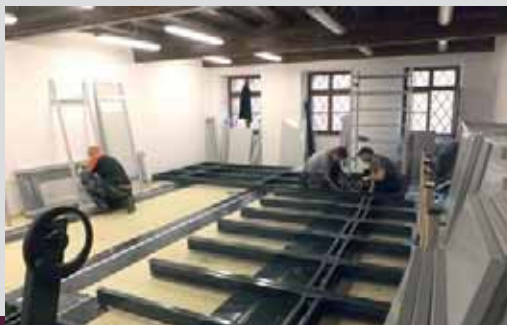
Rekonstrukce knihovny – instalace regálového systému
