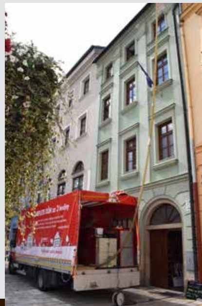
Zateplování půdy na budově 55 v Jihlavě
