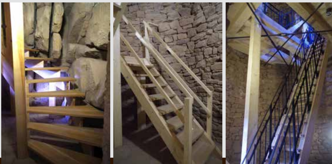
Instalace schodů a zábradlí v hradní věži
