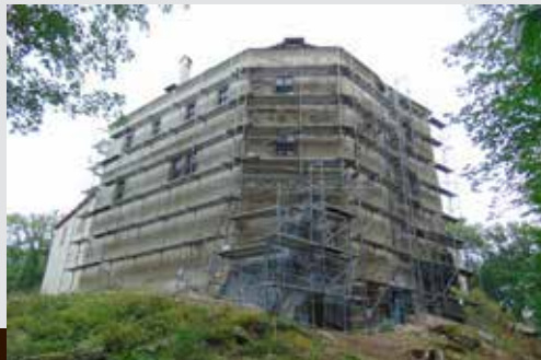
Práce na fasádách hradu vedoucích směrem do lesa
