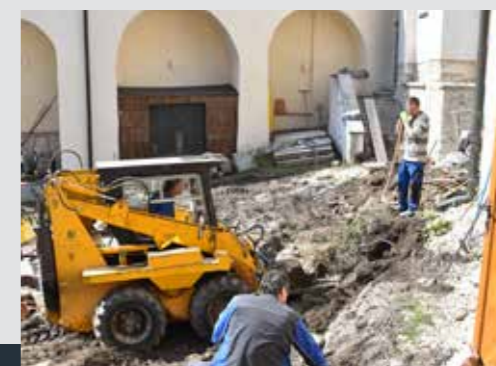
Práce na zápraží před zázemím správy hradu
