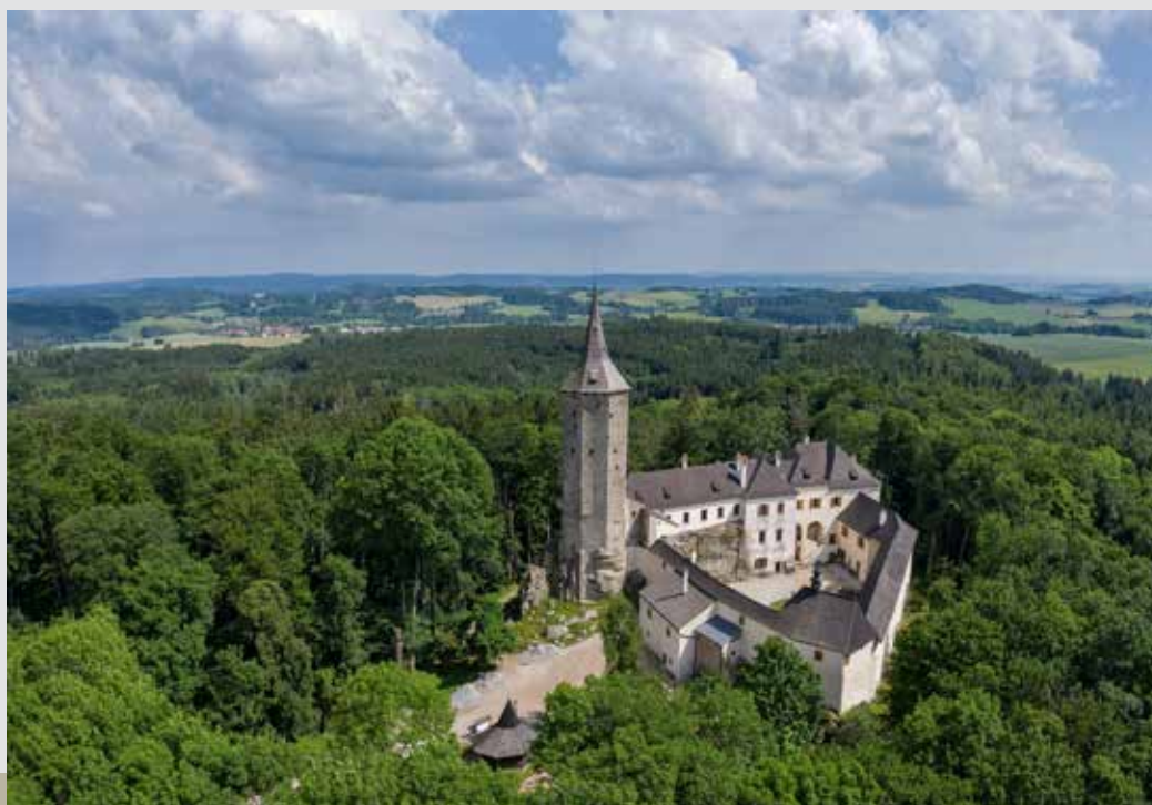
Panoramatický pohled na hrad Roštejn
