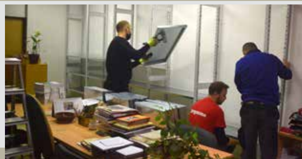
Stavba nového regálu
