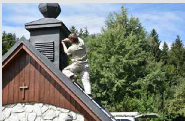
„Rozebírání“ kaple – zpřístupnění zvonu pro dokumentaci
