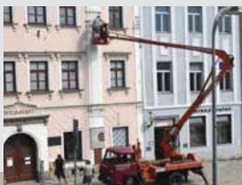
Průzkum stavu fasády na expoziční budově v Jihlavě
