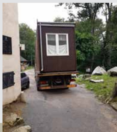
Odvoz zázemí stavby
