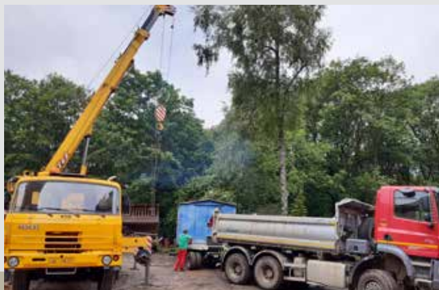
Likvidace zázemí stavby
