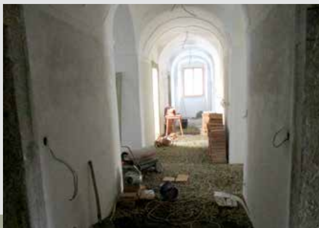
Pohled do rekonstruovaných prostor areálu, kde bude instalována dlouhodobá výstava
