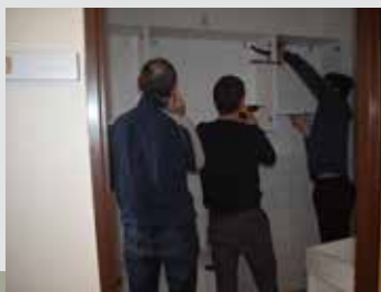
Montáž nové kuchyňské linky na budově č. 55 v Jihlavě
