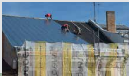
Pokládání nové krytiny
