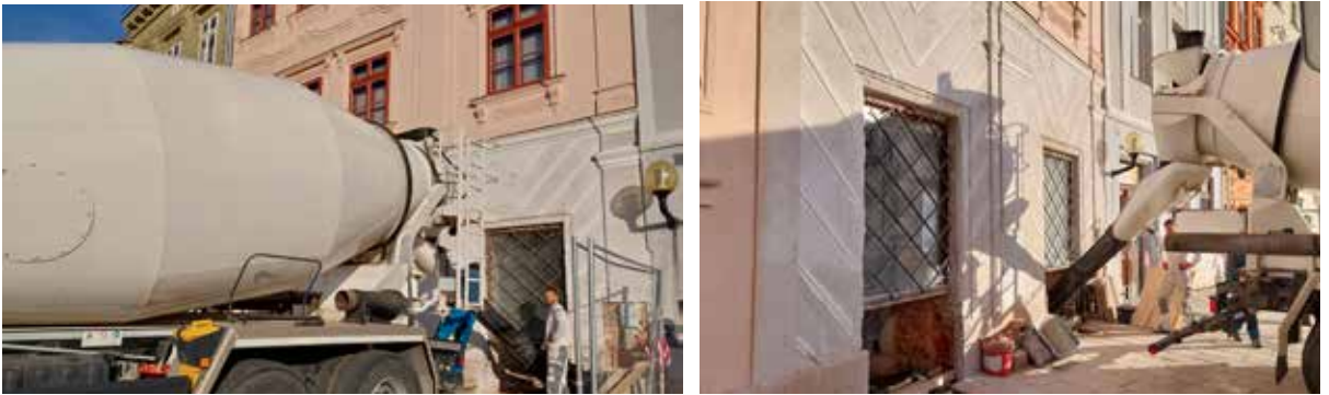
Stavební práce v přízemí expozičních budov
